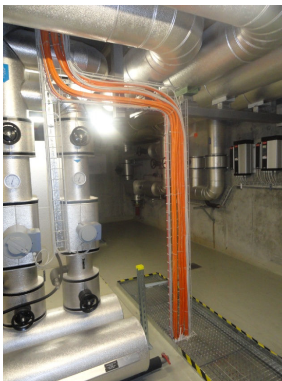
Rys. 1 Typowy widok pomieszczenia technicznego.
