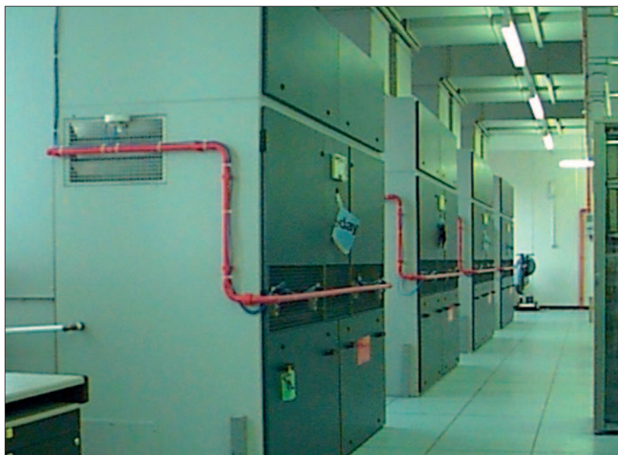
Rysunek 3. System ssący zainstalowany na szafach z urządzeniami telekomunikacyjnymi w centrali telefonicznej.
