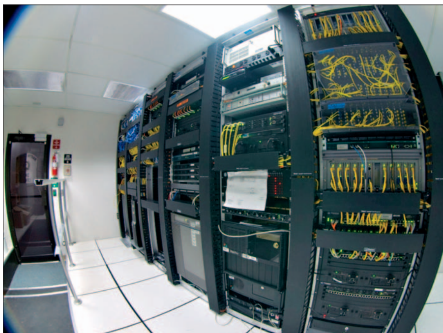
Rysunek 1. Pomieszczenie z wyposażeniem telekomunikacyjnym (autor: Gregory Maxwell).
