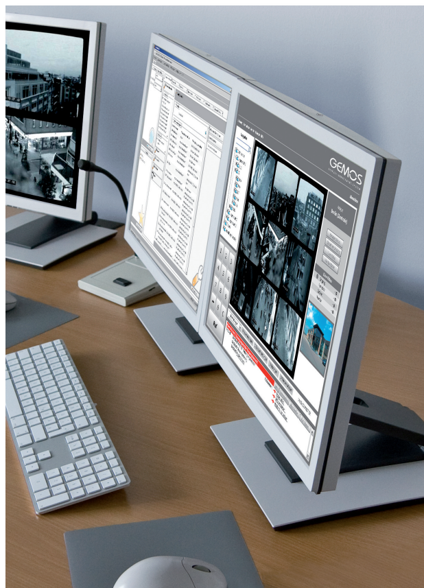
Stanowisko systemu integrującego i wizualizującego systemy bezpieczeństwa w budynku
