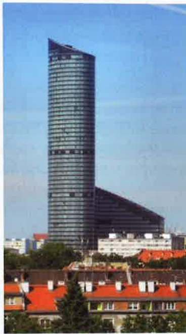
Wrocław SKY TOWER 212 m (biura, mieszkania, galeria handlowa)
